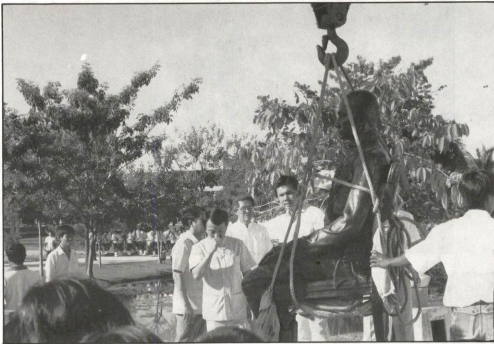
ช่างบนพร้อมแล้ว ยกขึ้นได้
