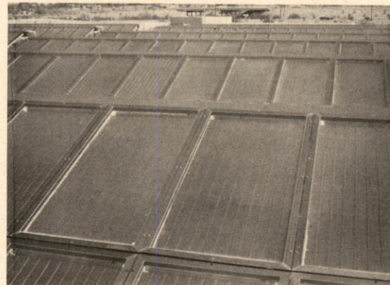
รูปที่ 3 แผงรับแสงอาทิตย์สำหรับระบบทำความเย็นในอาคาร เมืองฟินิกซ์ อะริโซนา
