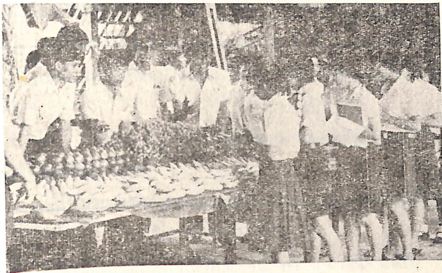
เลขงดองคือนรับน้องใหม่
